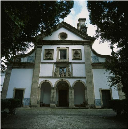
Figura 3. Vista da Igreja de Santa Teresa.
