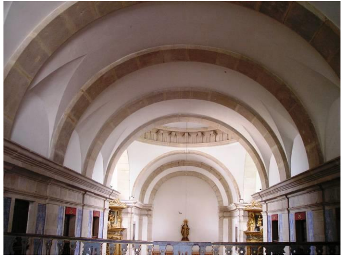
Figura 4. Vista da abóbada da nave.
