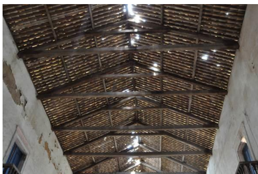
Figura 6. Tesoura de linha baixa e alta da nave.
