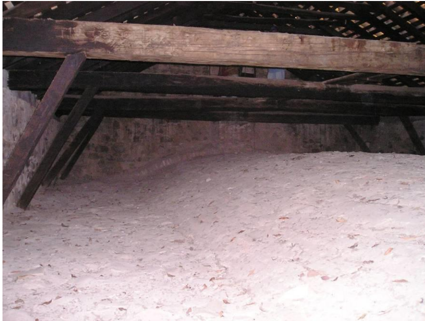
Figura 6. Vista superior da abóbada, do enchimento lateral e das tesouras.
