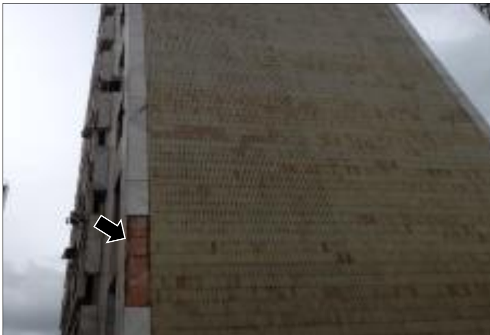
Figura 5. Fachada oeste (trecho T8).
