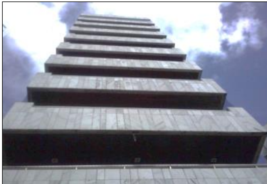
Figura 3. Fachada leste (trecho T1).
