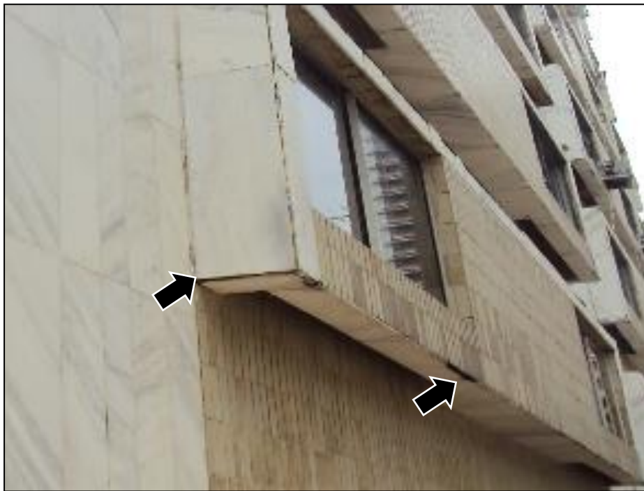
Figura 2. Fachada norte (trechos T5, T6 e T7).
