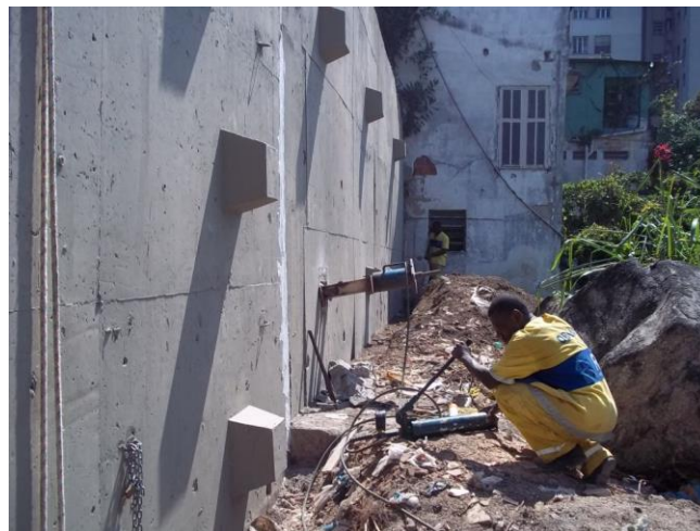
Figura 7. Ensaio de verificação residual de carga em andamento.
