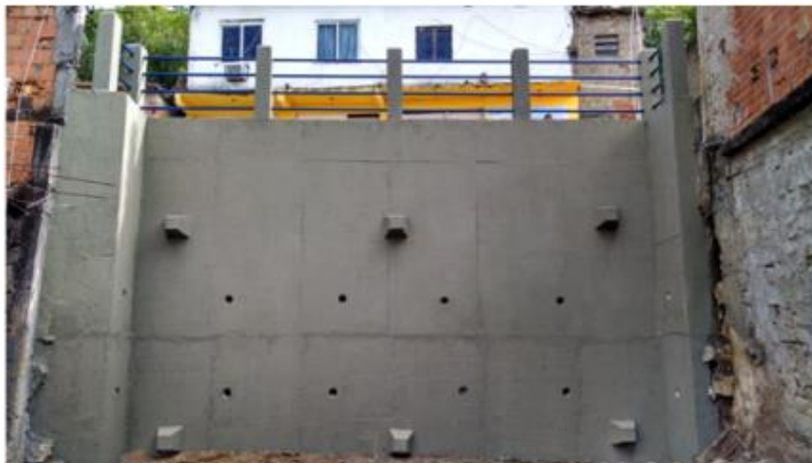
Figura 2. Vista de uma cortina ancorada em área de risco geotécnico: (Autor)
