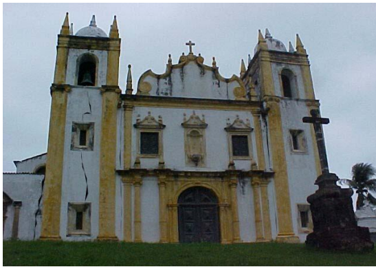
Figura 3. Danos Estruturais na Igreja do Carmo em meados dos anos 2000. Fonte: Acervo Público de Olinda.
