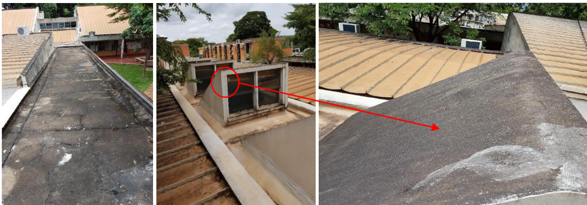
Figura 9, Figura 10 y Figura 11. Estructura de soporte sin techo / claraboyas.
