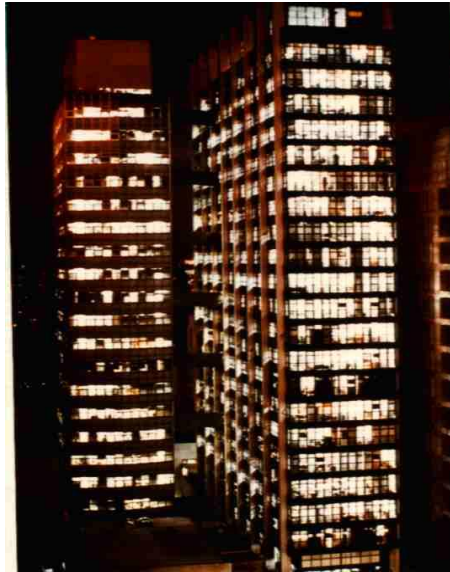
Figura 7. Edifícios Sede I e Sede II da Companhia Energética de São Paulo - CESP
