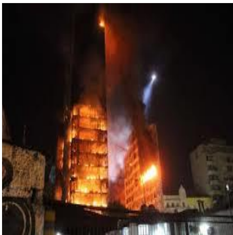
Figura 5. Edifício Wilton Paes de Almeida submetido a incêndio em 01/05/ 2018
