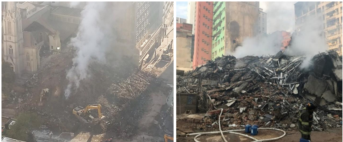
Figura 2. Edifício Wilton Paes de Almeida após o seu colapso (fonte: acervo pessoal de Paulo Helene).
