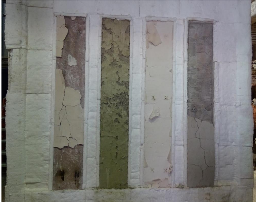
Figura 4. Detalhe da condição dos elementos e revestimentos, após abertura do forno (evento 1): revestimento com gesso formulado liso, elemento de referência, revestimento com gesso projetado e revestimento com argamassa cimentícia.
