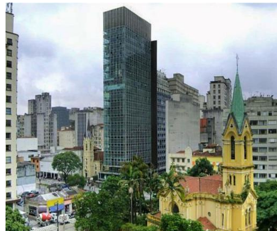
Figura 4. Edifício Wilton Paes de Almeida, localizado no centro da cidade de São Paulo
