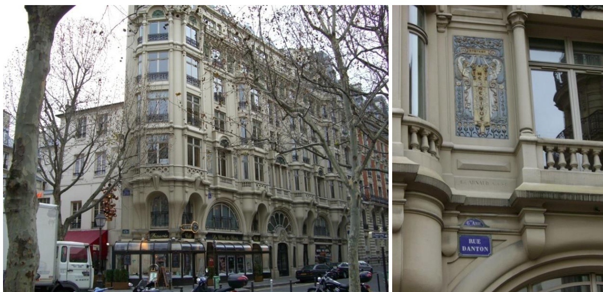
Figura 4. Primeiro edifício do mundo concebido com o sistema Hennebique (119 anos de bons serviços prestados à sociedade) (fonte: acervo pessoal de Paulo Helene).
