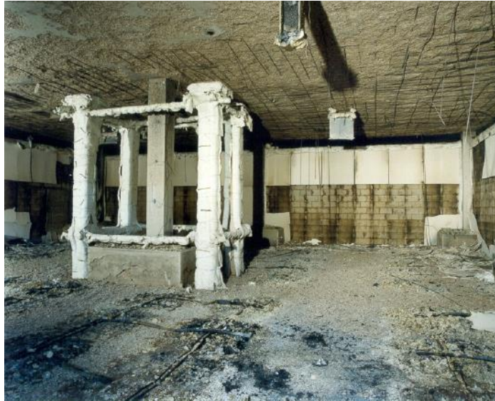
Figura 18. Detalhe da extensão e da severidade da ocorrência de spalling nas lajes ( f_{ck} = 74 MPa) após a simulação de incêndio. No destaque, observar as condições de integridade do pilar de concreto de alta resistência ( f_{ck} = 103 MPa) (Chana & Price, 2003).
