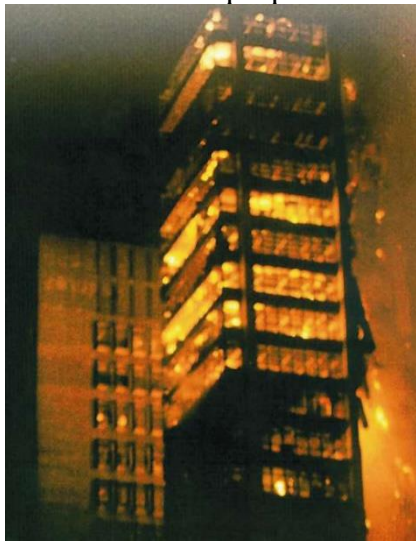
Figura 16. Parte frontal remanescente do edifício Sede II
