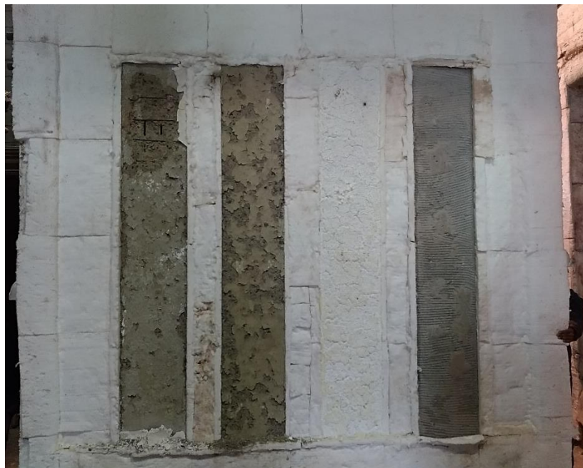
Figura 7. Detalhe da condição dos elementos e revestimentos, após abertura do forno (evento 2): revestimento com gesso liso lento popular de mercado, elemento de referência, revestimento com tinta intumescente e revestimento com argamassa cimentícia.
