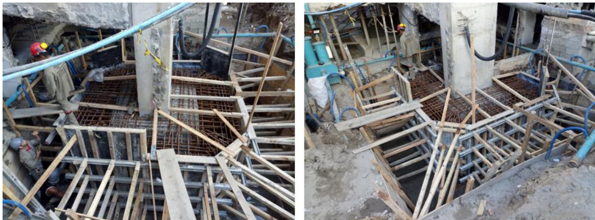
Figura 14. Detalhe das fôrmas do reforço estrutural dos blocos de fundação.
