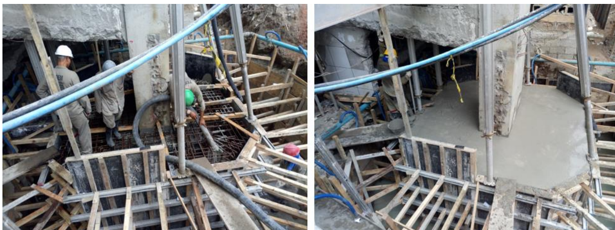
Figura 16. Detalhe da concretagem do reforço do bloco de fundação, realizado com concreto autoadensável.
