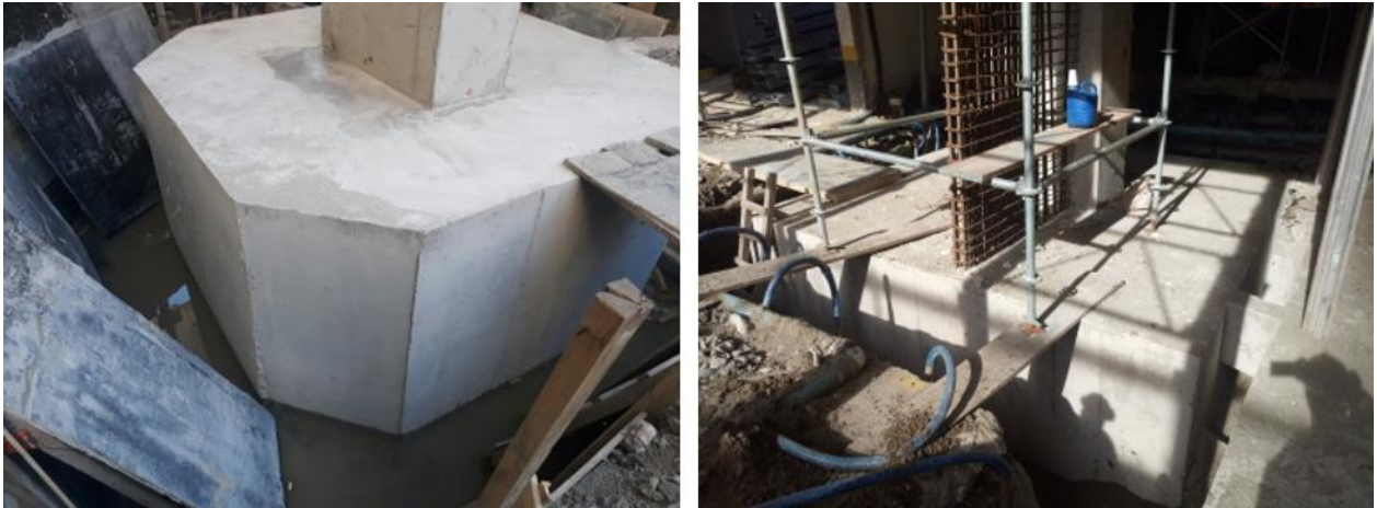
Figura 17. Detalhe do aspecto visual e do acabamento superficial do concreto dos blocos de fundação reforçados.
