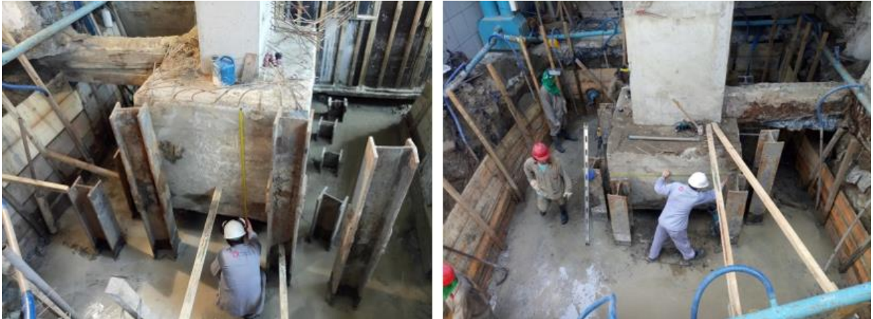
Figura 9. Detalhe da aferição das dimensões dos blocos existentes e das estacas metálicas, após escavação e execução do magro.
