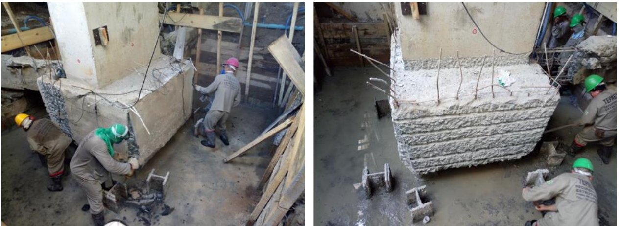
Figura 10. Detalhe da execução dos chanfros e sulcos nas arestas e superfícies laterais dos blocos de fundação.
