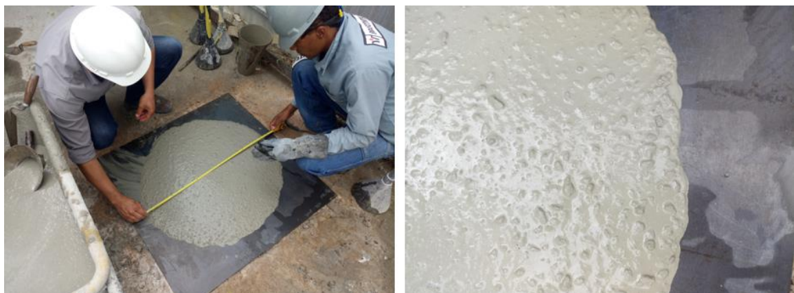
Figura 15. Aspecto visual do concreto autoadensável utilizado no reforço dos blocos estruturais.
