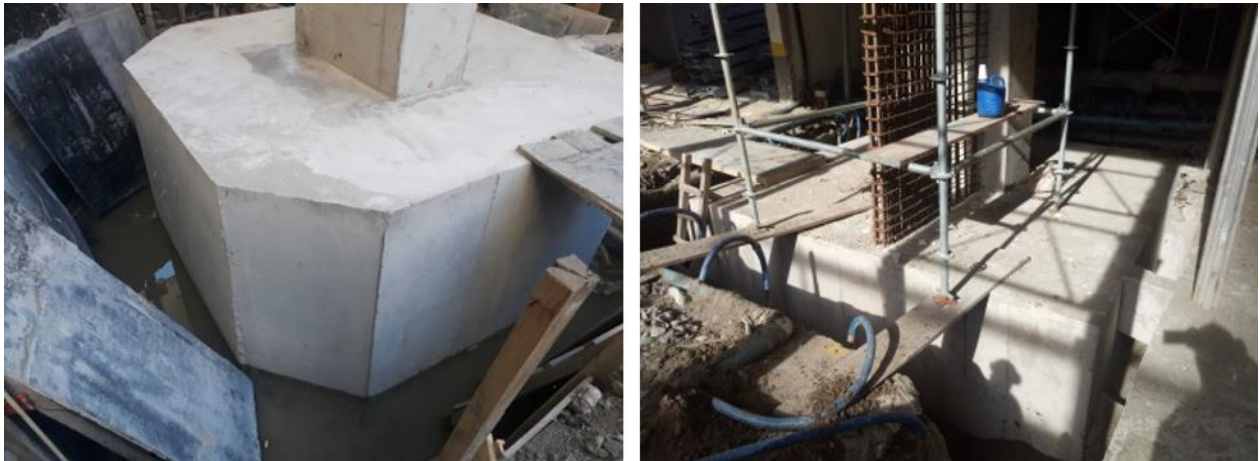
Figura 17. Detalle del aspecto visual y del acabado superficial del concreto de los encepados de cimentación reforzados.
