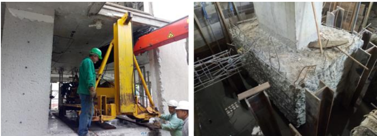
Figura 8. Detalle de la ejecución de los trabajos de conducción (a la izquierda) y de los pilotes metálicos clavados en el entorno del bloque de cimentación a ser reforzado (a la derecha).
