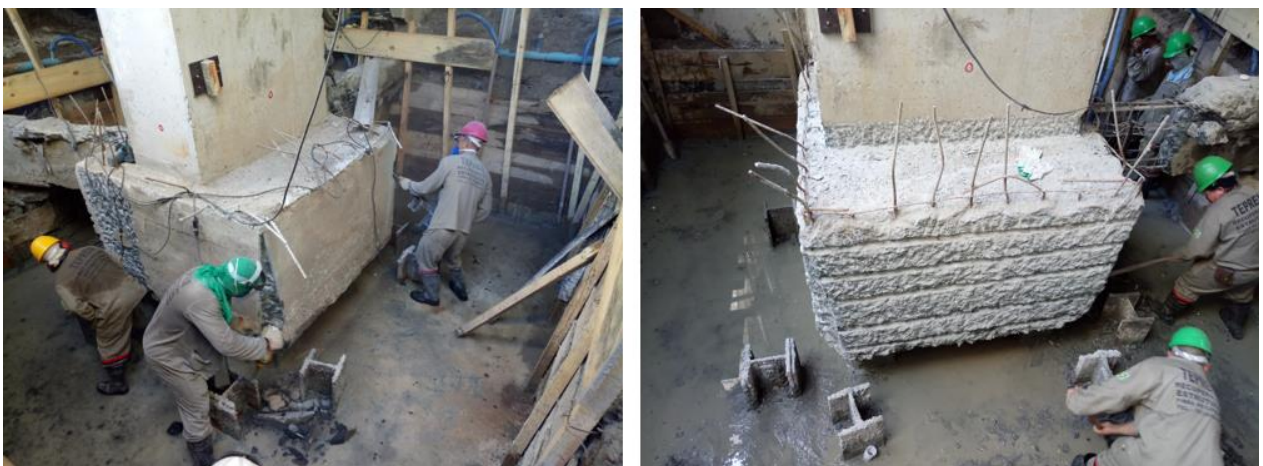
Figura 10. Detalle de la ejecución de los chaflanes y surcos en las aristas y superficies laterales de los encepados de fundación.
