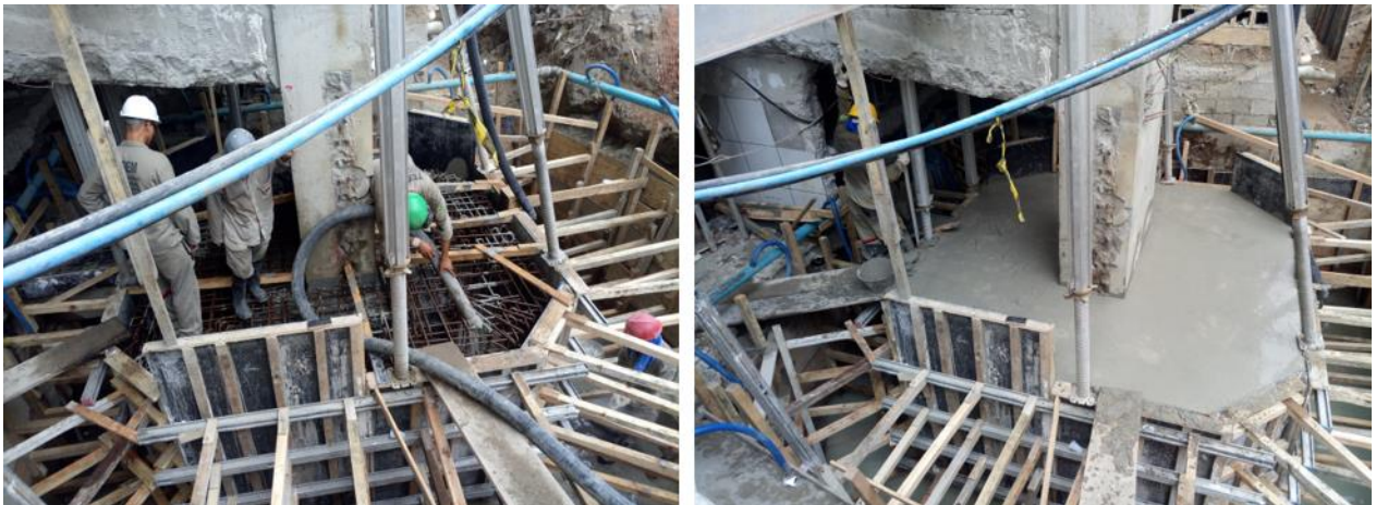
Figura 16. Detalle del vaciado del refuerzo del bloque de fundación, realizado con concreto autocompactante.
