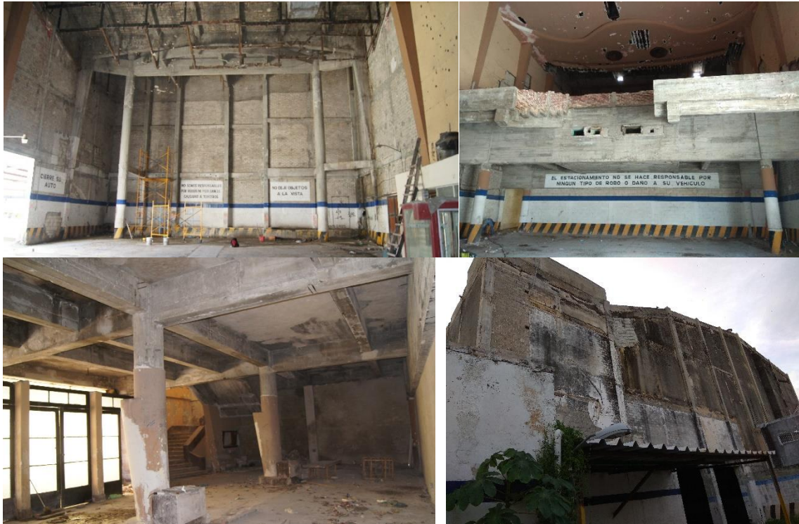
Figura 2. Estado da estrutura antes de ocorrer a intervenção
