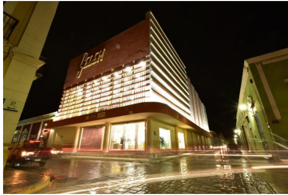
Figura 7. Vista noturna do edifício após intervenção
