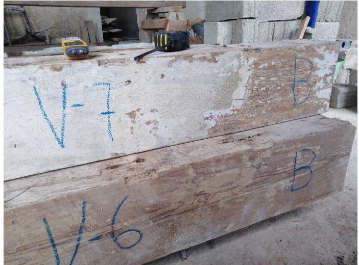
Figura 8. Identificação de vigas de madeira
