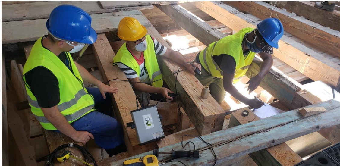
Figura 9. Aplicação de testes VPU em vigas de madeira
