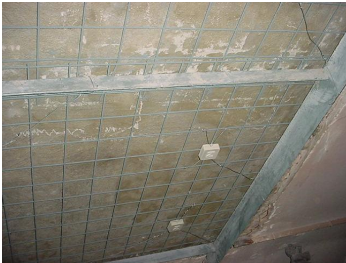
Figura 5. Tela metálica e pastilhas Z. (Fonte: Arquivo da Equipe do Projeto de restauro do MNBA)
