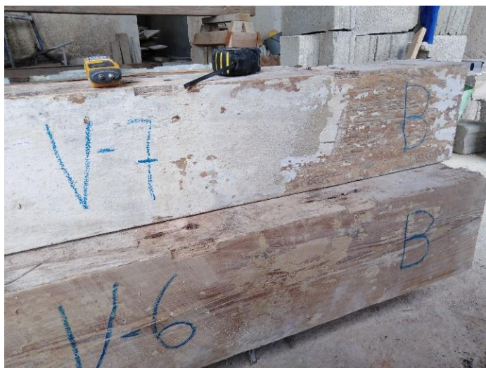
Figura 8. Identificación de las vigas de madera
