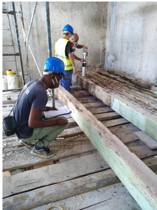
Figura 4. Inspección y clasificación visual de vigas desmontadas
