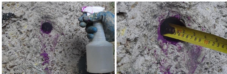
Figura 4. Muro de pozo húmedo con hormigón alcalino.
