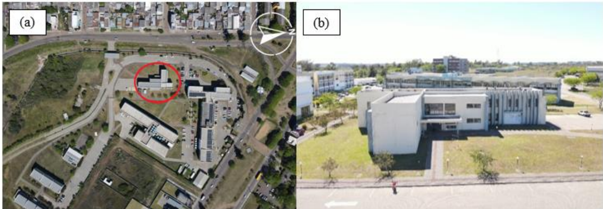
Figura 3. Edificação de estudo: a) Localização da edificação no Campus da UNIPAMPA em Alegrete/RS; b) Fachada de acesso a edificação DTIC.
