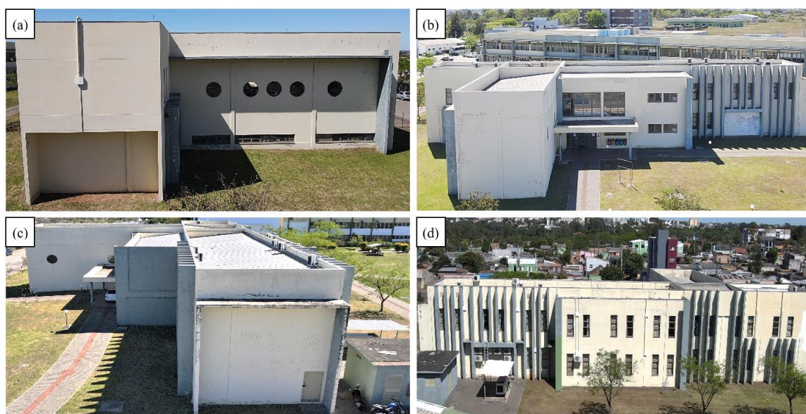
Figura 11. Fachada Norte (a), Fachada Oeste (b), Fachada Sul (c), Fachada Leste (e) antes da revitalização.
