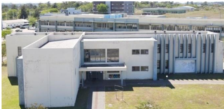
Figura 5. Fachada Oeste antes da revitalização.
