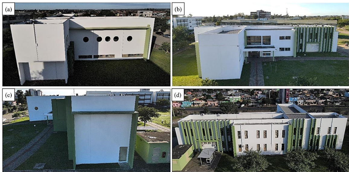
Figura 12. Fachada Norte (a), Fachada Oeste (b), Fachada Sul (c), Fachada Leste (e) após revitalização.
