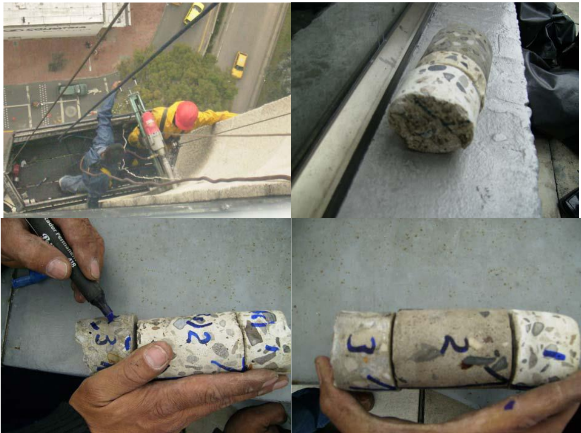
Figura 1. Extracción de núcleos (1A: Extracción de las muestras con el sistema de perforación con broca de diamante; 1B: Recuperación de núcleos de la fachada; 1C y 1D: Marcaje de las muestras que involucran material del prefabricado de fachada (1), del concreto de pega prefabricado-estructura (2) y de la estructura (3))
