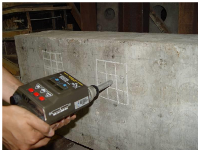
Figura 3. Execução do Ensaio de Esclerometria.
