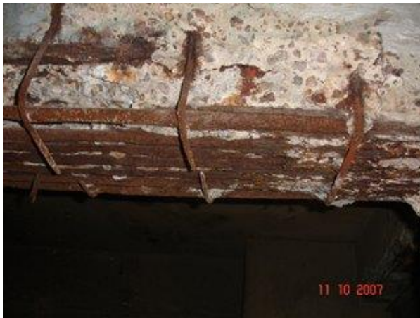
Figuras 13 y 14. Estado de la Viga N° 21 una vez eliminada la reparación anterior.
