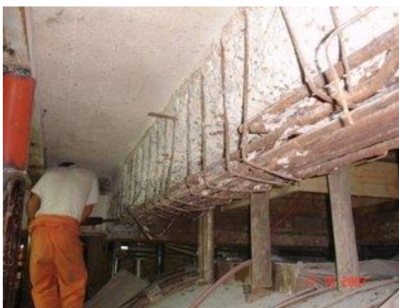
Figura 15. Eliminación mecánica del hormigón afectado en la viga N° 21
